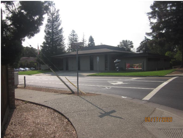
Los Altos Fire Station
