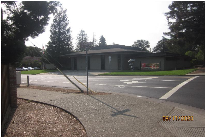
Los Altos Fire Station
