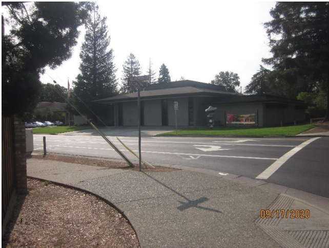
Los Altos Fire Station
