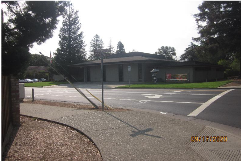
Los Altos Fire Station
